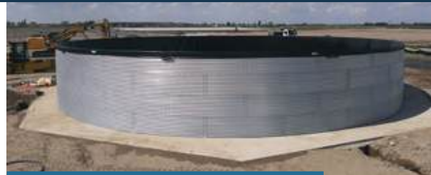
(Lagosanto, 2021) Si noti il cordolo esagonale antisismico di cemento armato. Queste riserve idriche sono l'ideale per grandi stoccaggi d'acqua per l'irrigazione nei vivai appunto, anche in terreni con presenza di acqua di falda superficiale.
