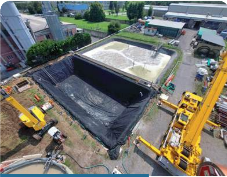
(Filago, BG, 2023) Una vasca interrata per il trattamento delle acque reflue per lo stoccaggio di prodotti chimici di risulta dal processo industriale, impermeabilizzata con telo EPDM 1,5 mm. gofrato. La foto è scattata da una PLE e mostra anche il lago di depurazione adiacente in funzione contenente soda caustica per la correzione del PH.
