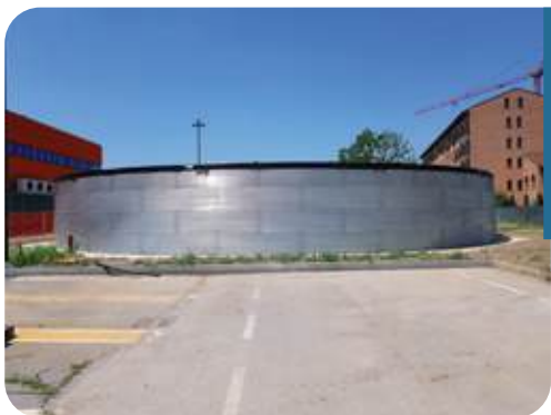
(Rozzano, provincia di Milano, 2019) Riserva idrica, destinata all'impianto antincendio di un negozio di arredamento. Altezza: 3,12 metri Diametro: 23,67 metri. Spessori lamiere: 1° anello dal basso 2 mm, 2° anello 1,6 mm, 3° anello 1,2 mm, 4° anello 1 mm. Volume nominale: metri cubi 1373. Voume utile antincendio (considerando 1 metro di ghiaccio): metri cubi 720.
