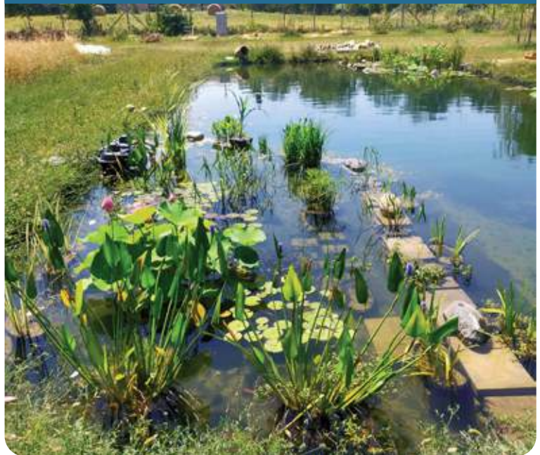
(Parma, 2022) Questo è un vero biolago balneabile naturale: è possibile notare infatti 2 zone di rigenerazione con la piante fitodepuranti e la filtrazione naturale è realizzata in totale assenza di cloro. Al centro la profondità di oltre 2 metri permette i tuffi: consigliamo la visione del filmato con tuffo e con timelapse di costruzione, nella nostra videogallery su www.benza.it
