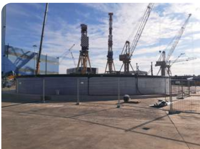
(Marghera, provincia di Venezia, 2021) Cisterna di acciaio misure \varnothing 27,31 H 2,36 destinata a test di carico e scarico gru in un cantiere navale, poggiata su cordolo di cemento armato e sabbia al centro.
