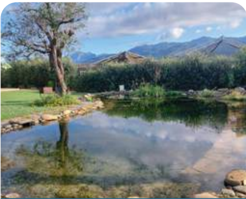
(Camaione, 2024) A distanza di 2 anni dalla realizzazione, il biolago balneabile naturale presenta un'acqua pulita e trasparente e si può notare la crescita delle piante da fitodepurazione, nella zona di rigenerazione in fondo alla foto.
