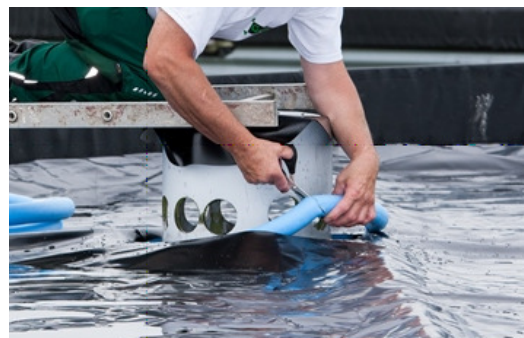
Installatie ring rondschuim / installation foam ring
